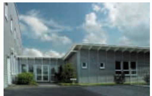
■ Centre de service KABELSCHLEPP à Hünsborn.
