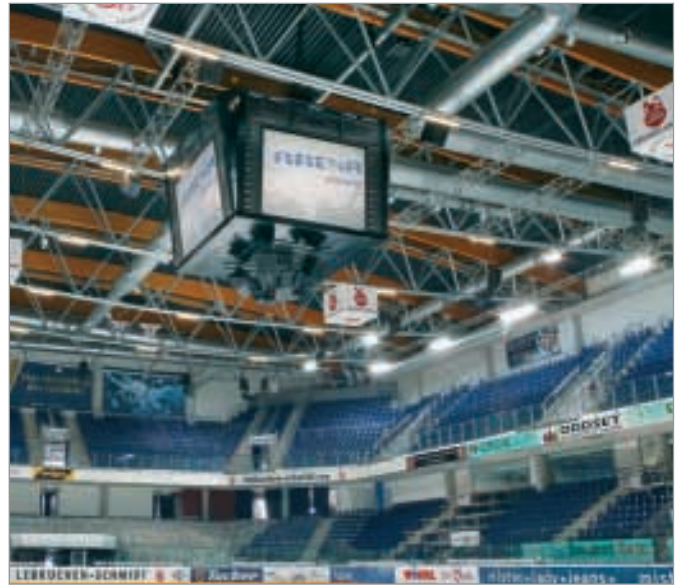
Porte-câbles UNIFLEX en zig-zag sur une installation multimédia mobile Arena – Nürnberg
