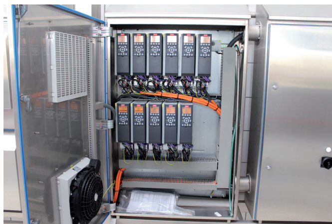
Les entraînements à vitesse variable permettent d'harmoniser de façon précise la vitesse des convoyeurs.
