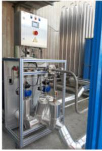
L'échangeur de chaleur Eco Chiller N2 d'Air Liquide recycle en temps réel le froid généré par la vaporisation des gaz dans un système de refroidissement. A l'heure actuelle, de nombreux procédés industriels utilisant du gaz et de la chaleur nécessitent, en parallèle et simultanément, un système de refroidissement
